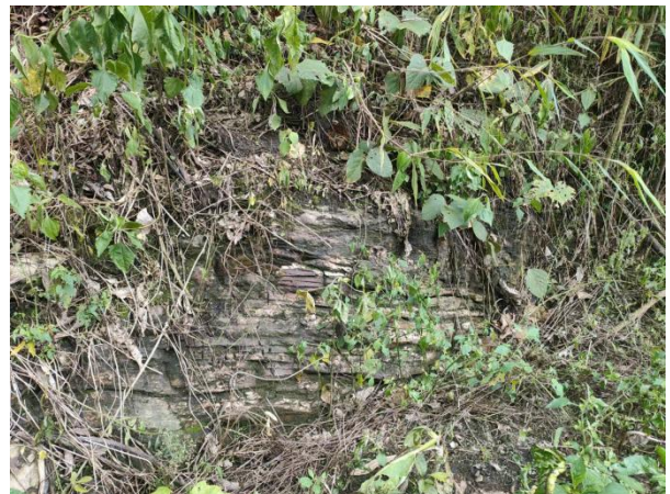
照片3-3 坡脚出露基岩
