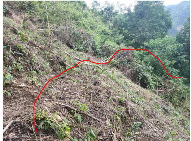
照片 4.2-3 滑坡左后缘局部变形
