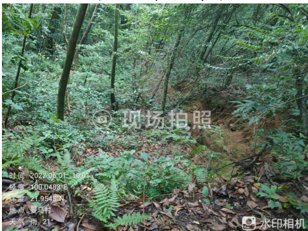
照片 4-4 滑坡右侧错坎
