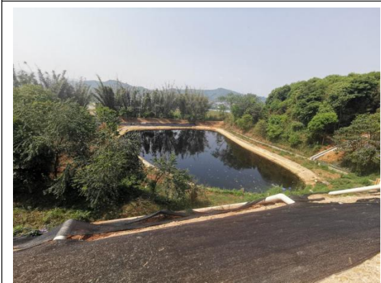
渗滤液调节池
