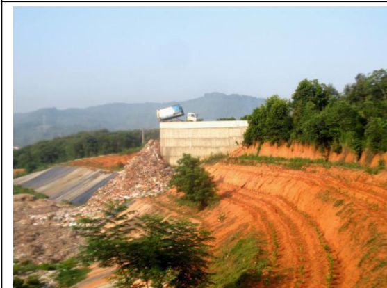
填埋场垃圾倒台
