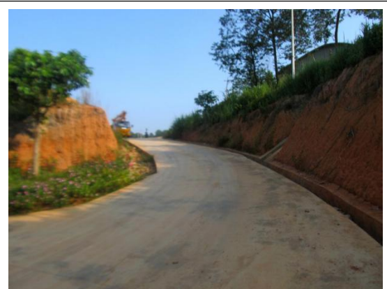
填埋场环场路
