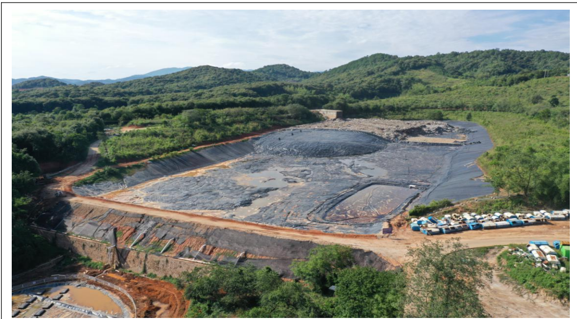
填埋库区现状
