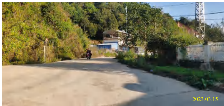
项目东侧环境现状
