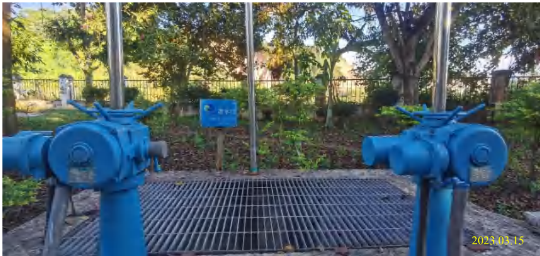
项目现有进水口
