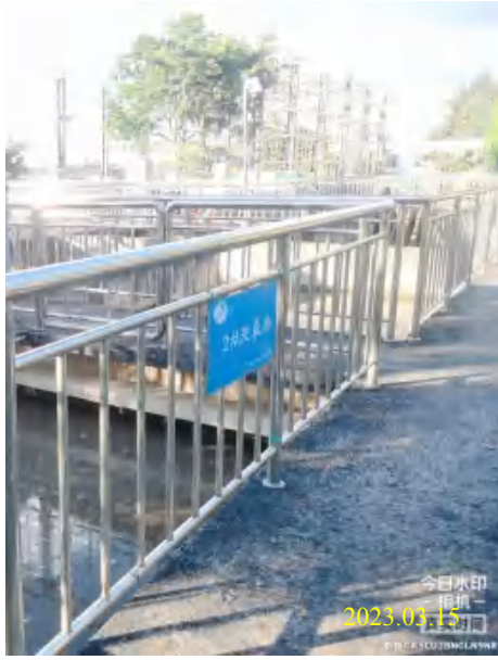
现有污水处理（厌氧池）
