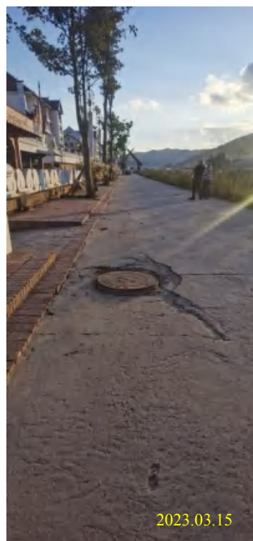
管网工程现状
