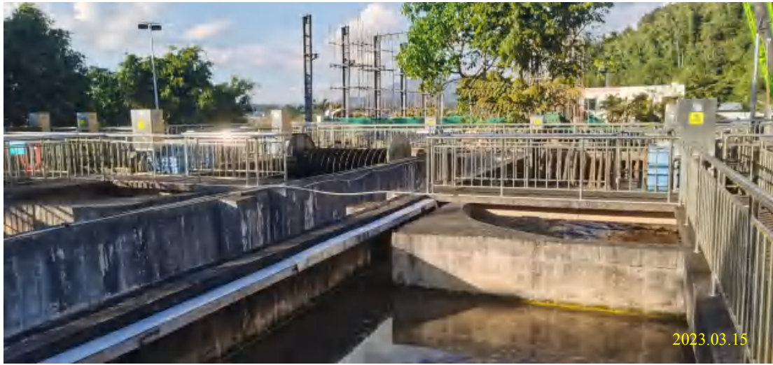
现有项目污水处理区
