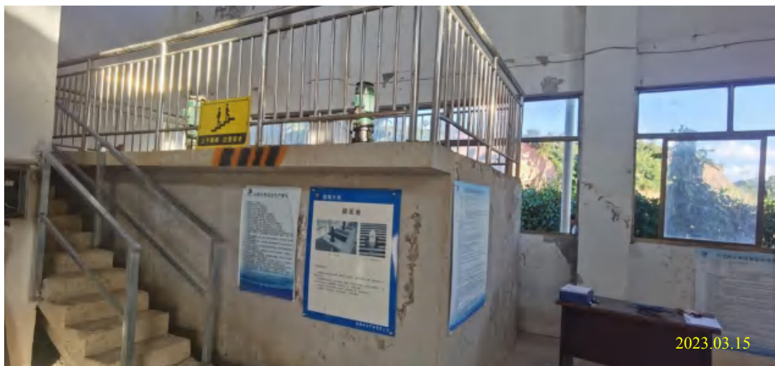
项目现有贮泥池
