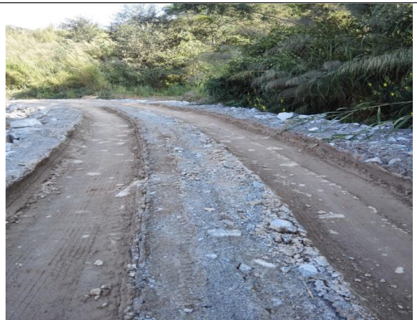
矿区道路现状
