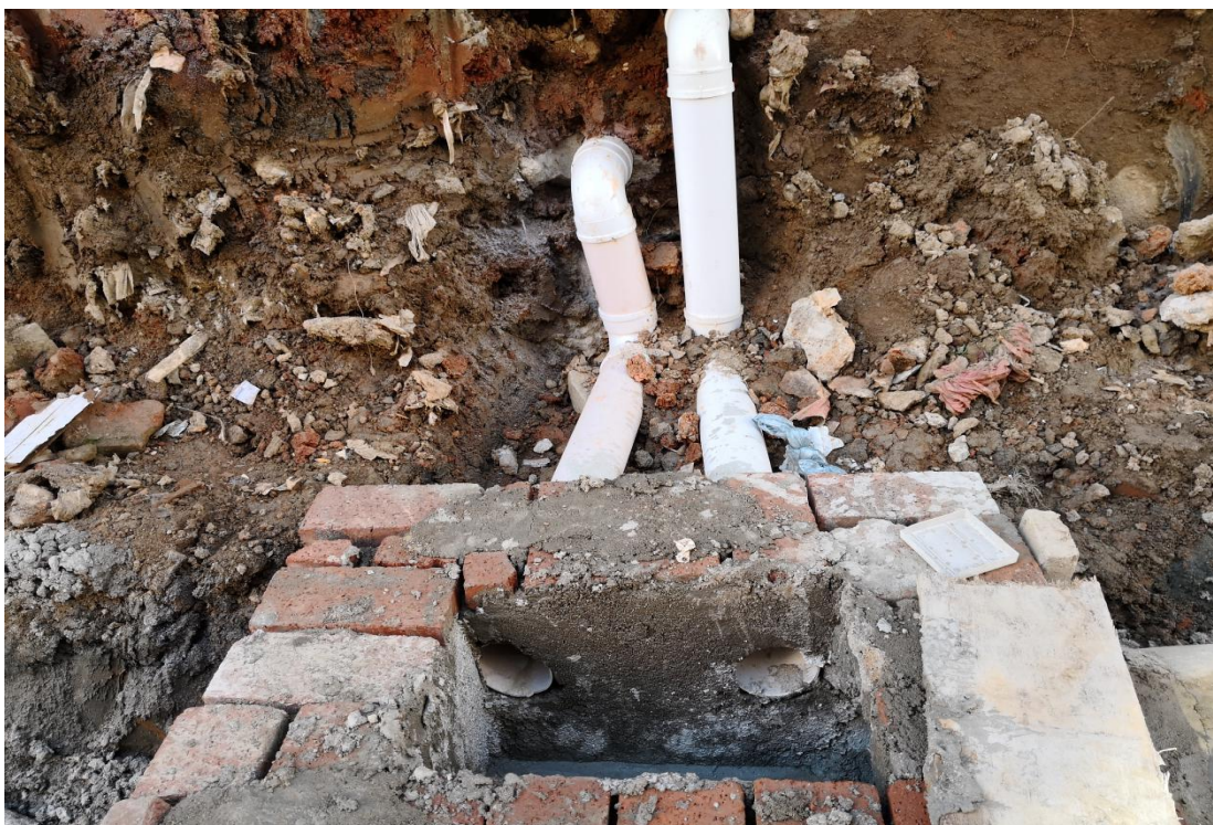
改造期间临时管网接入市政污水管网（五号地块）
