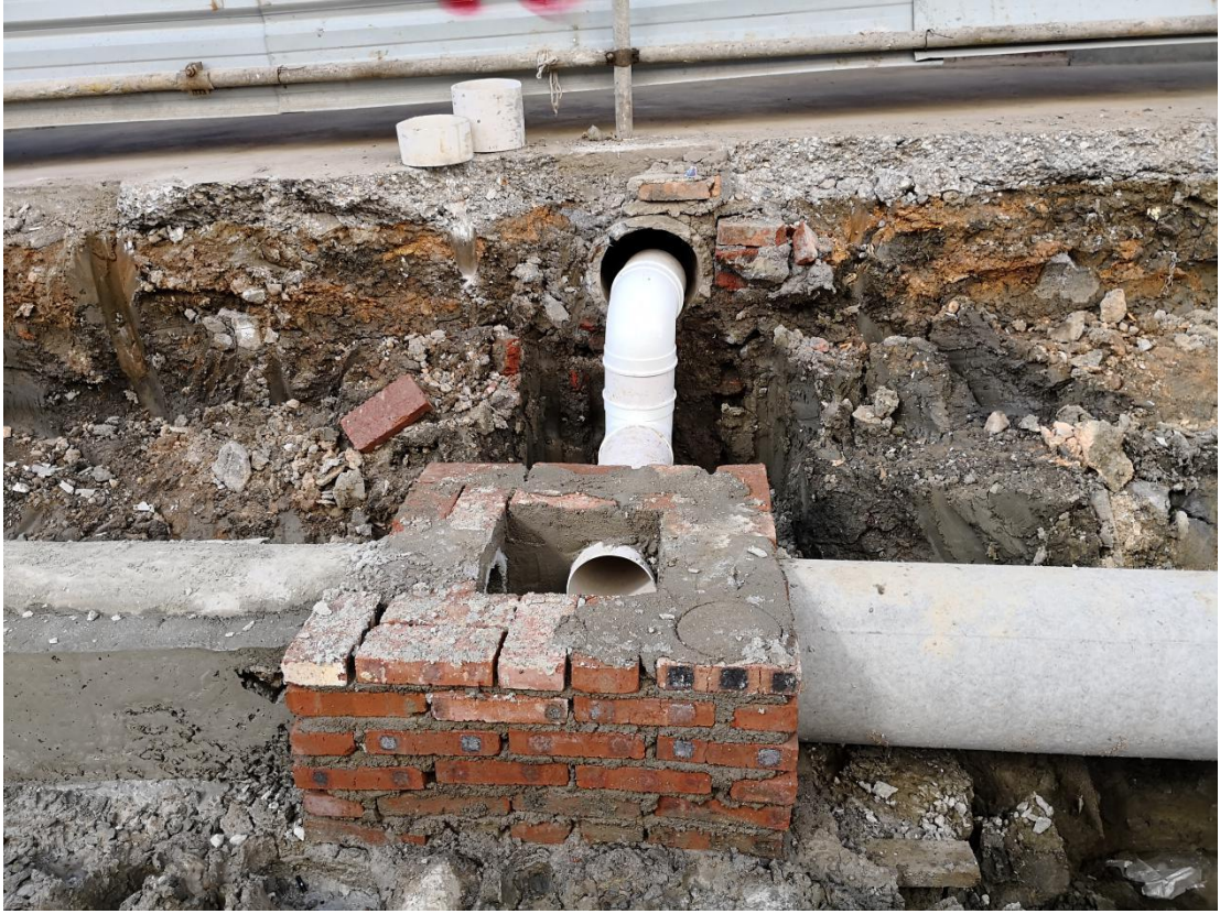
改造期间临时管网接入市政污水管网（五号地块）
